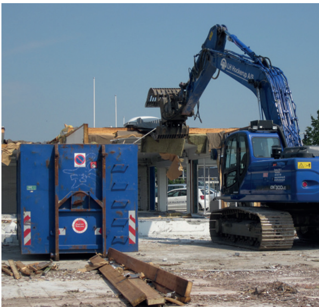
Nedrivning hvor affaldet sorteres umiddelbart.
