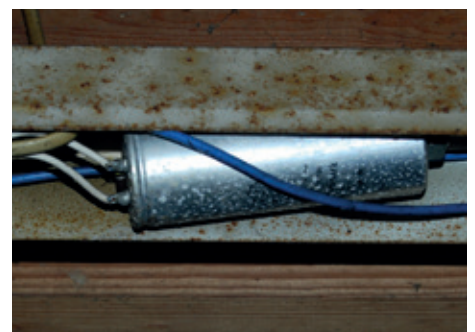
Ældre kondensatorer indeholder ofte PCB.
