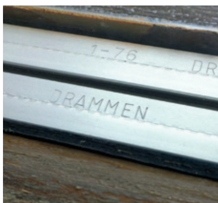
Prægningen i rudens afstandsliste viser, at ruden er fremstillet i januar 1976 (1-76). Ruden kan derfor indeholde PCB.
