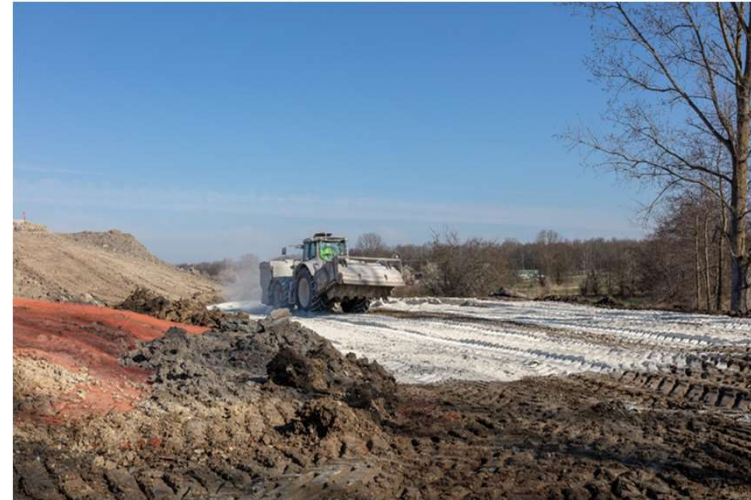
Kalkstabilisering af våd jord
