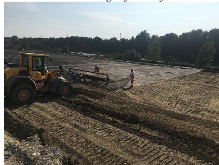
Jordarmeringsnet for skråningsstabilitet
