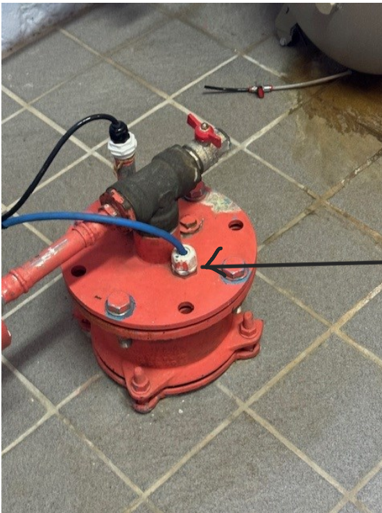
Boring 207.228 hvor kapelgennemføring ikke er helt fast (skal skiftes)
