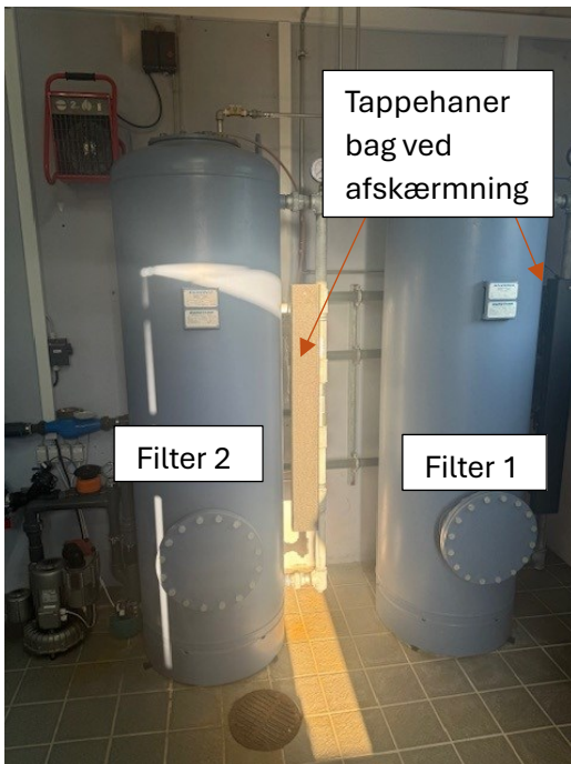
Filtre – et filter skylles for hver 54 m 3 , filtrene veksler
