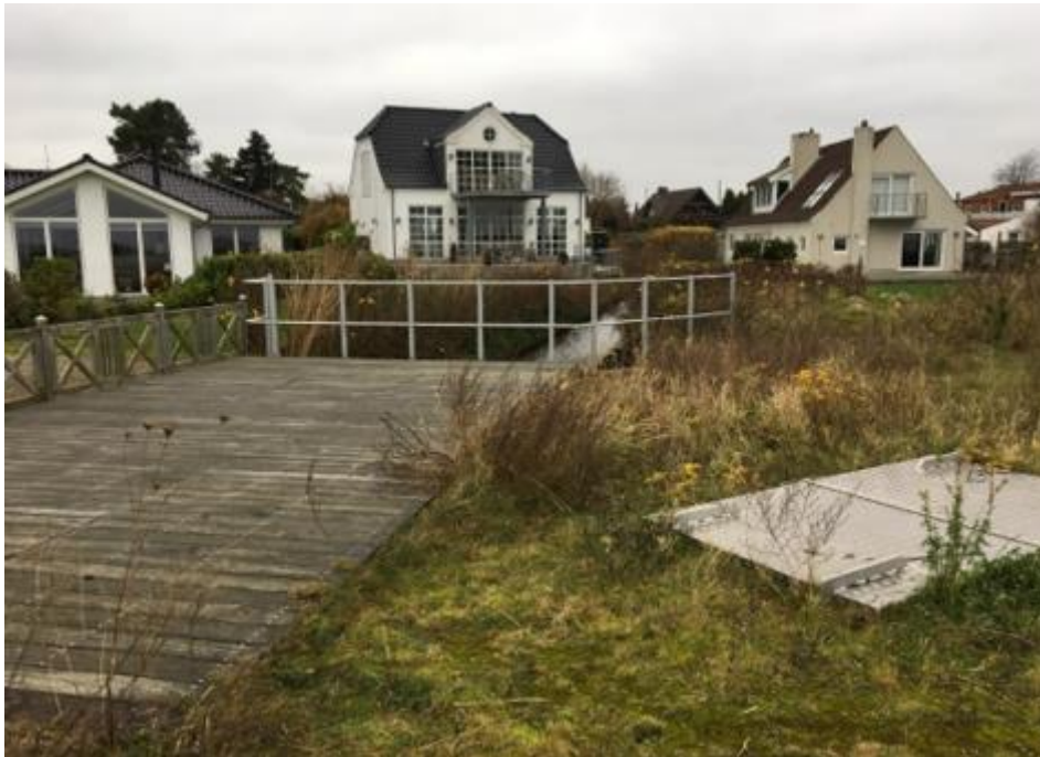
Figur 19: Indløb til pumpestation
