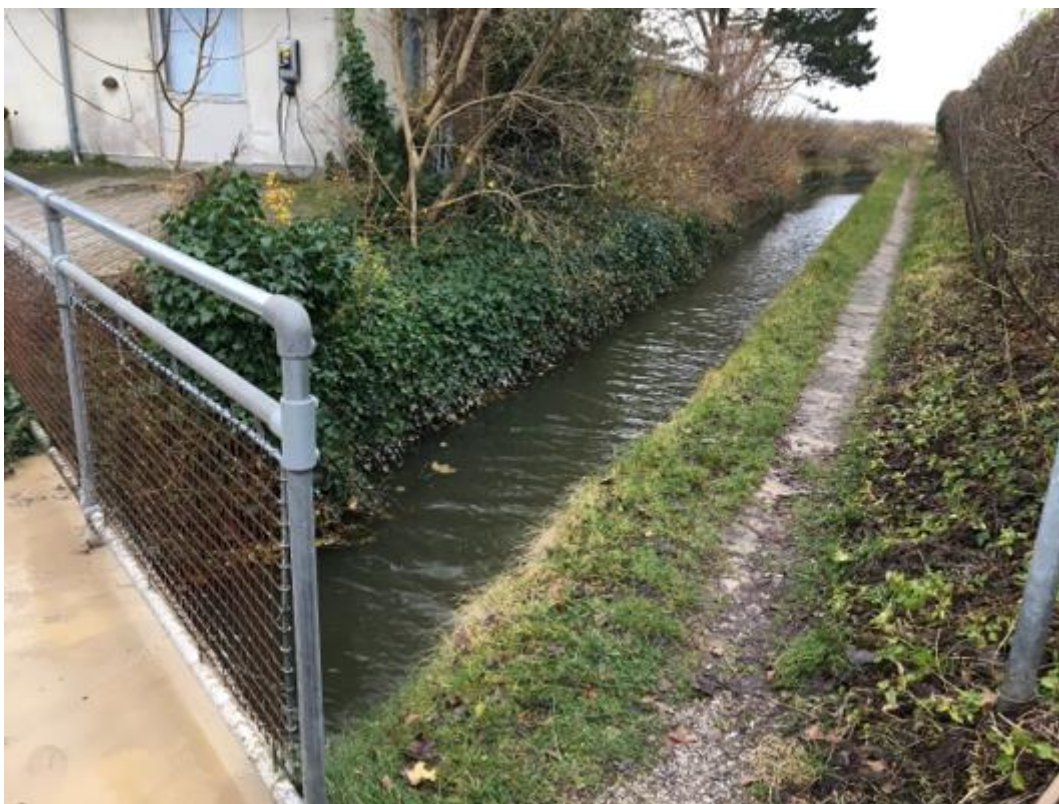
Figur 8: Nedstrøms Falkevej. Olsbæk løber i en betonkanal frem til strandarealet
