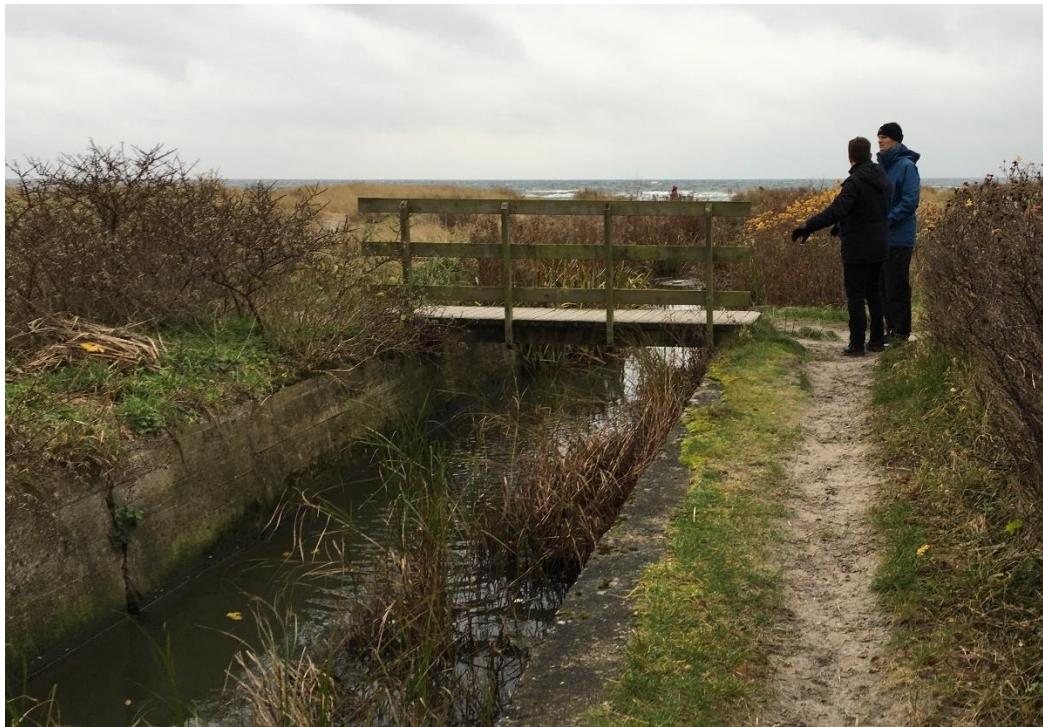
Figur 41: Eksisterende beton-trug/vægge ved Olsbækken, hvor evt. fremtidigt dige vil krydse bækken. Eksisterende bro nedtages og erstattes.
