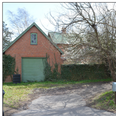
Niels Pedersensvej 9A Opført 1911
