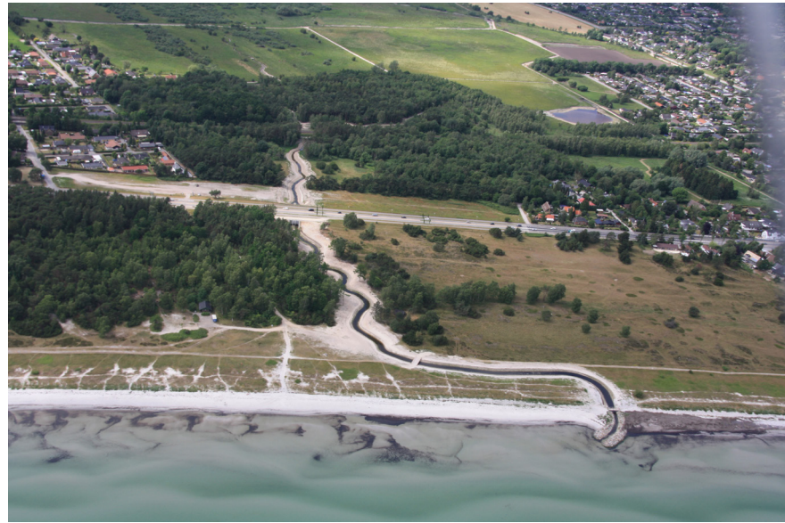
Klimasikring Karlstrup Mose
