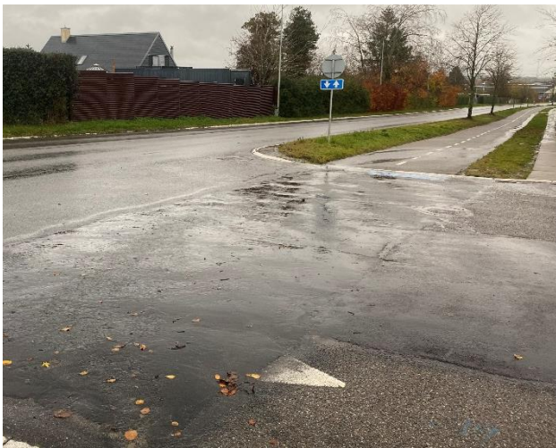
Figur 6. Utydelig afmærkning og uklar prioritering ved flere af sidevejene langs Tune Parkvej. Ind- og udkørsel ved Tune Center (t.v.) samt ved sidevejen Byagervej (t.h.).
