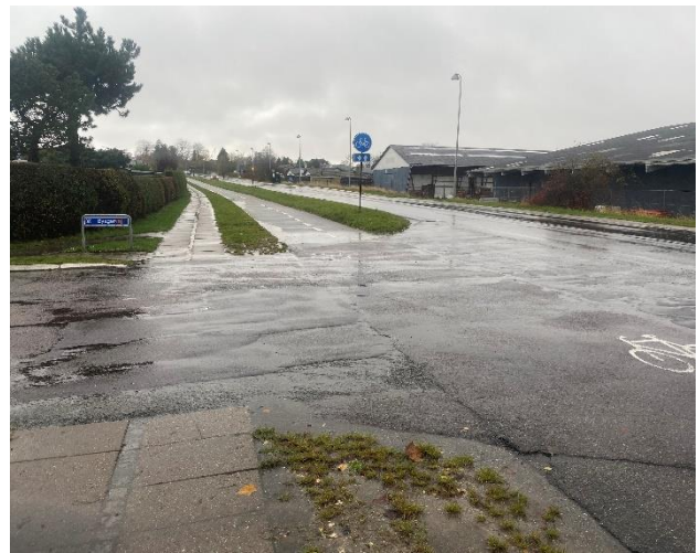
Figur 6. Utydelig afmærkning og uklar prioritering ved flere af sidevejene langs Tune Parkvej. Ind- og udkørsel ved Tune Center (t.v.) samt ved sidevejen Byagervej (t.h.).
