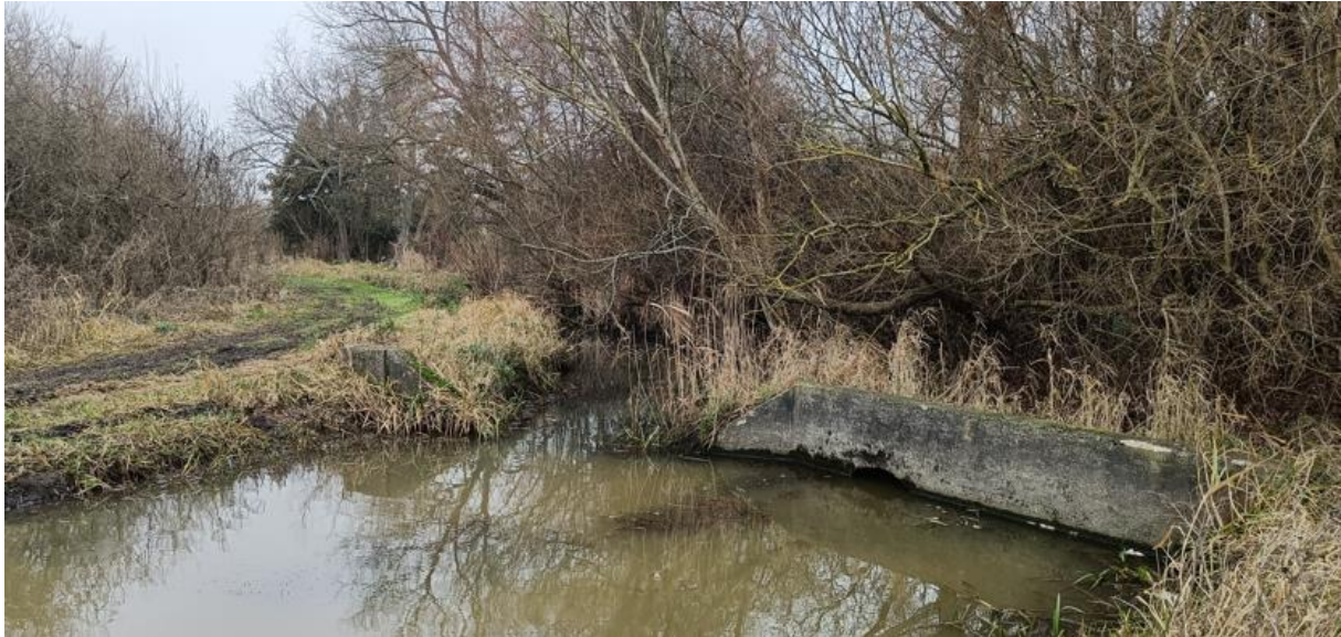
Foto 3.9 Eksisterende indløbsbygværk til sandfang. Det fjernes og der etableres et nyt, som er tilpasset den nye placering af rende.
