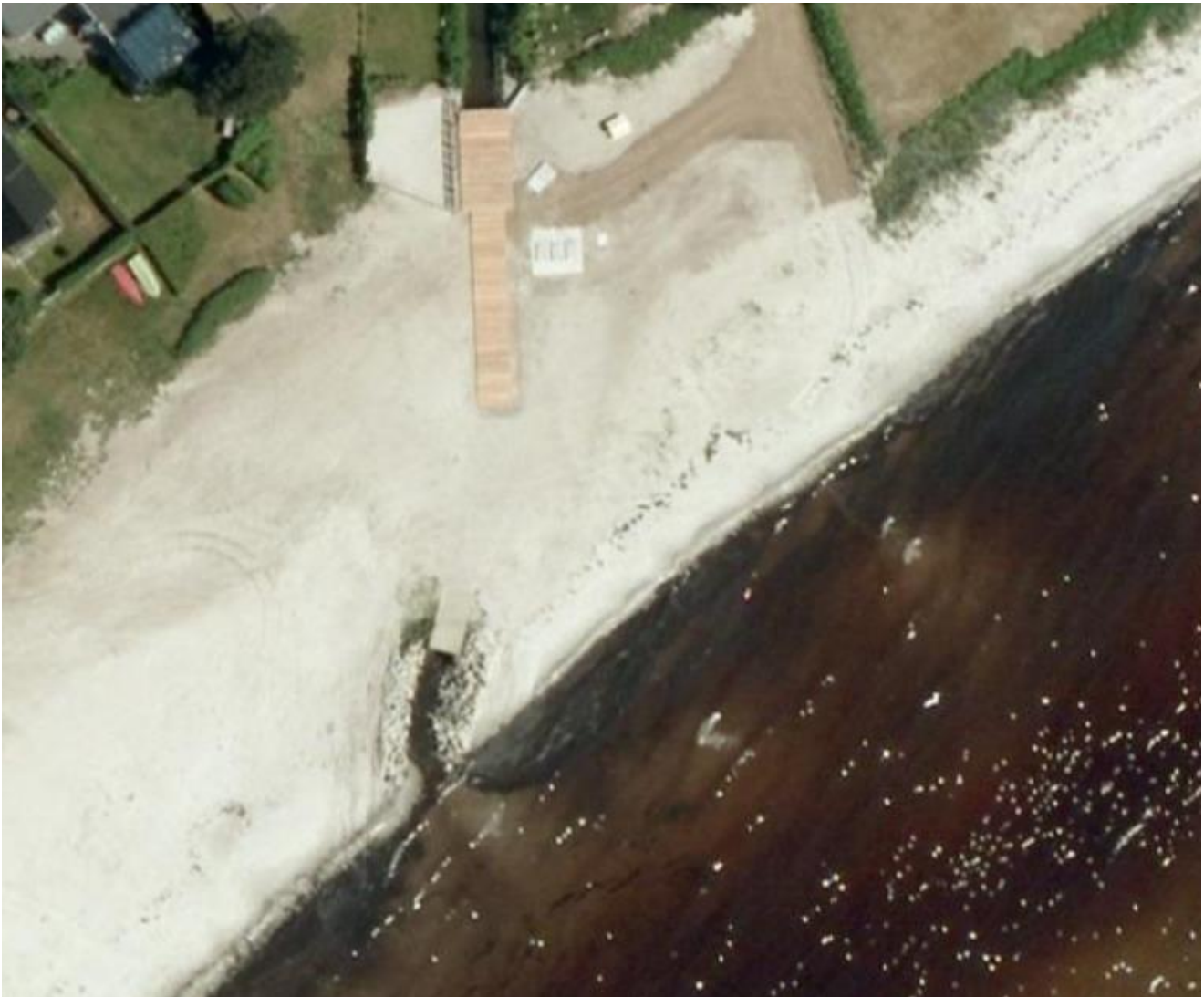
Figur 2.3: Ortofoto forår 2012 af udløbet efter etableringen af pumpestationen.
