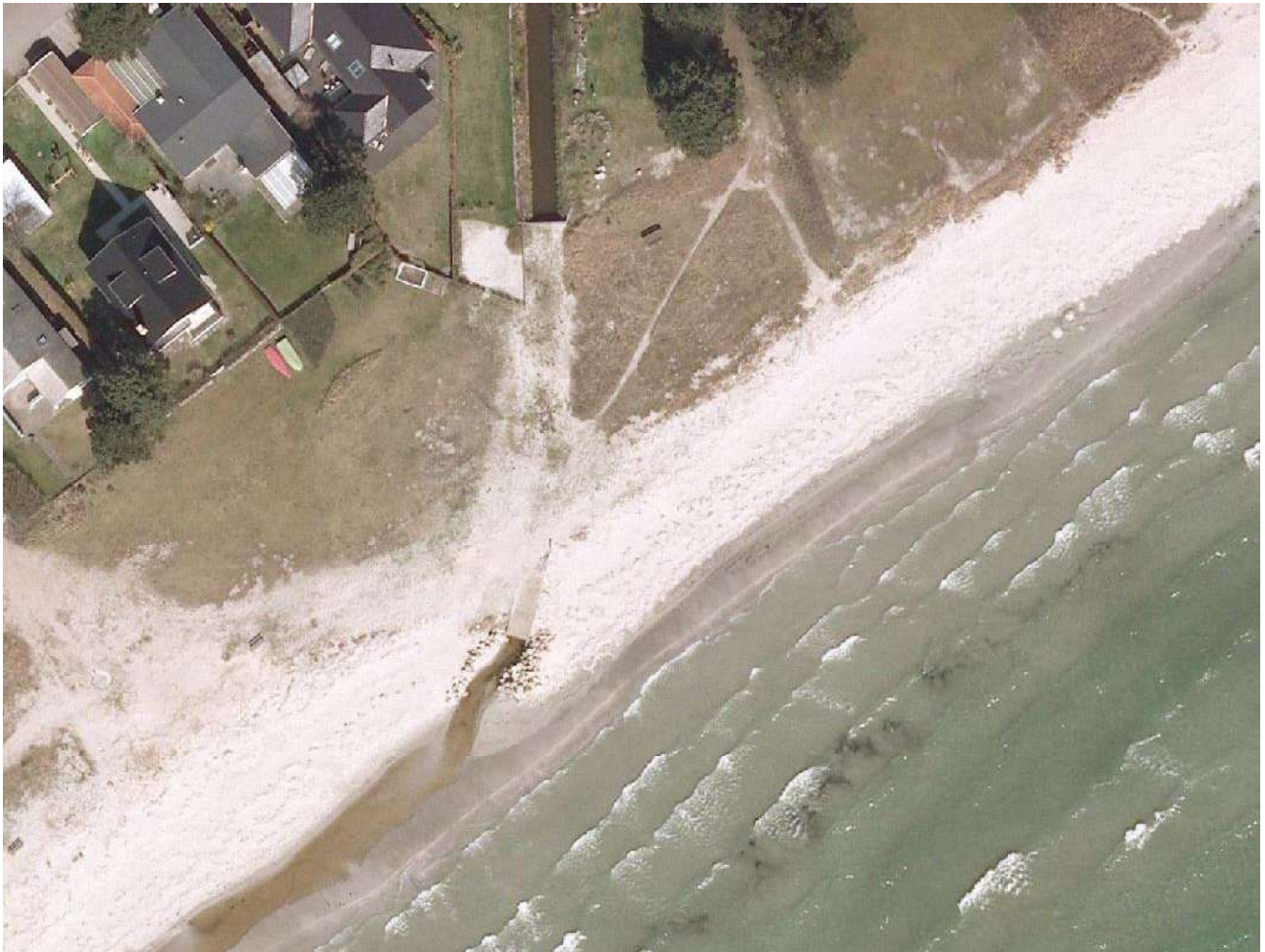
Figur 2.2: Ortofoto forår 2011 af udløbet før etablering af pumpestationen.
