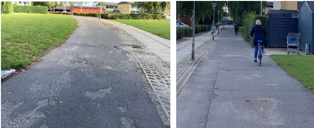
Billede 9: Vedligeholdelsen på stinettet kan nogen steder forbedres. På billedet er vist en kort strækning på Baneruten, hvor asfaltkvaliteten er dårlig.
