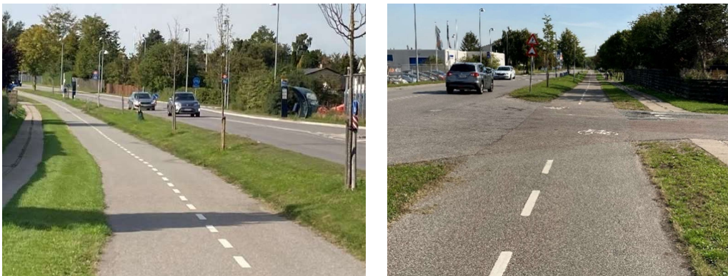
Billede 1: Dobbeltrettet sti på Tune Parkvej. Til venstre er stien uden krydsninger, som fungerer godt, da der ikke er usikre krydsninger. Til højre er vist krydsning ved Byagervej, hvor bilister uhensigtsmæssigt og unormalt skal orientere sig i begge retninger ift. cyklister. Det ses, at overkørslen har cykelsymboler, men i øvrigt ikke er afmærket yderligere. Dobbeltrettede stier i bynære områder er trafikfarlige.
